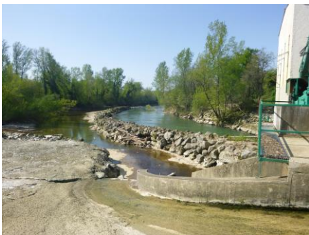
Centrale hydro-électrique à Saint-Maurice-sur-Adour
