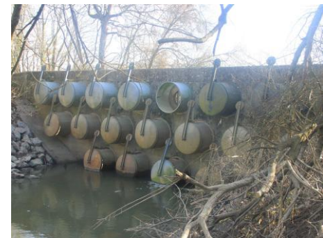
Clapets à la confluence de l'Adour et de l'Arroudet à Dax
