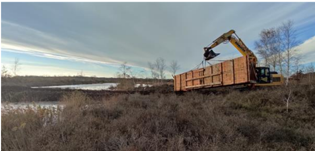
Installation d'un ouvrage hydraulique dans la tourbière du Grand Moura
