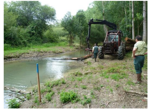
Installation des troncs dans l'eau avec l'ONF et une entreprise forestière
