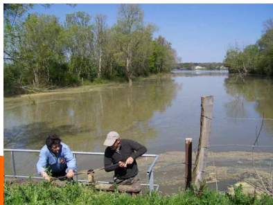
Entretien d'un ouvrage hydraulique dans les Barthes de l'Adour
