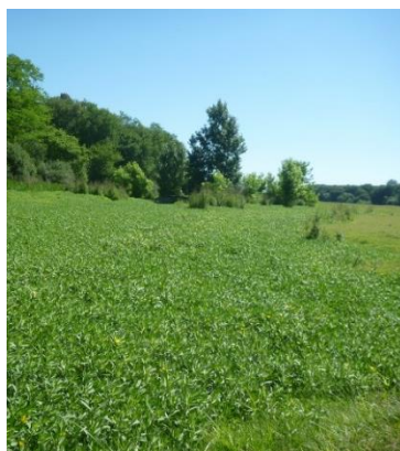
Berge de fossé dégradée par les terriers d'écrevisses américaines
