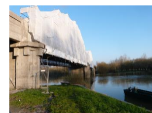
Travaux sur le pont de la Marquèze
