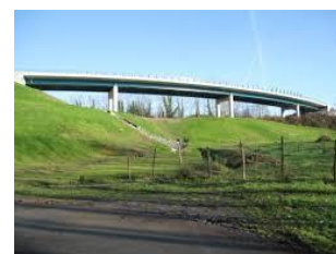
Viaduc du contournement Est de Dax
