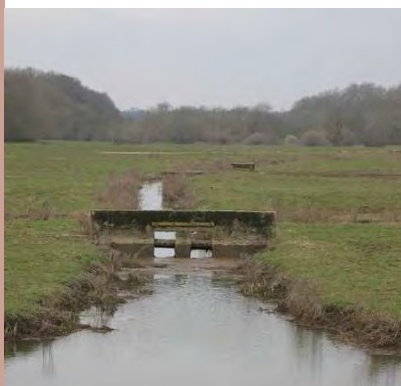
Seuils sur le canal d'Orist
